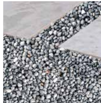
Colocación en seco sobre hierba, arena o gravilla
