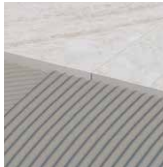
Colocación tradicional con cemento cola
